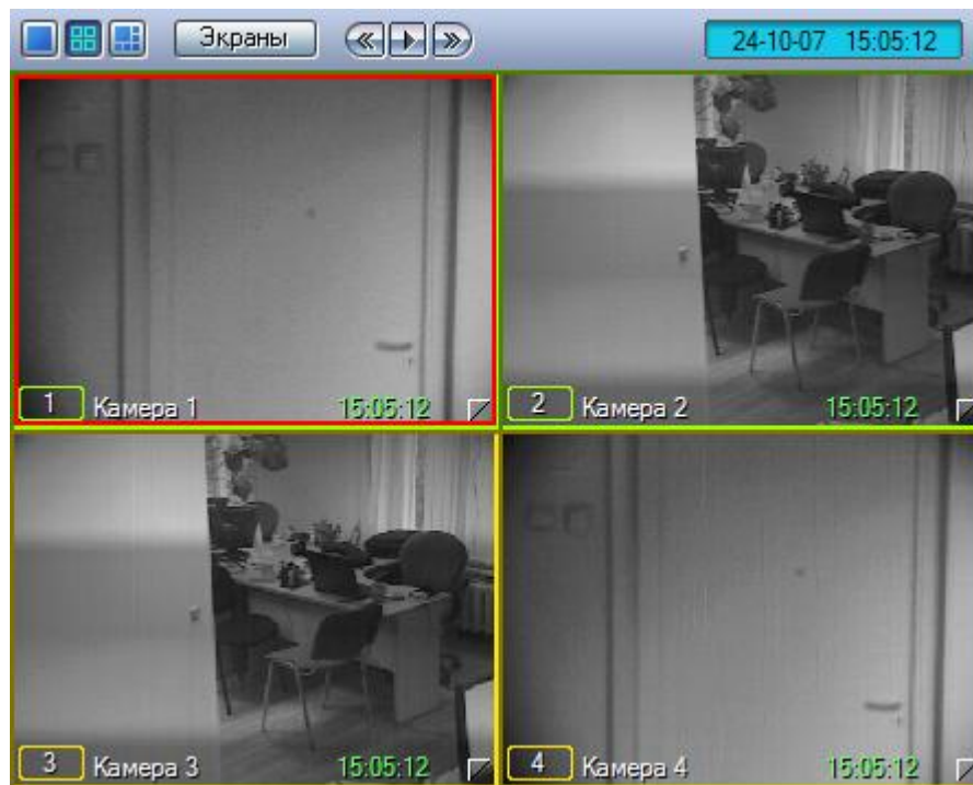
Рис. 4.5-1. Управление поворотными устройствами с помощью мыши
